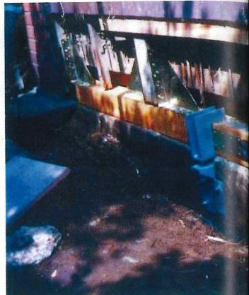
金属板をアングル状にした特製のML耐震補強工法。工事費の目安は1mあたり10万円
